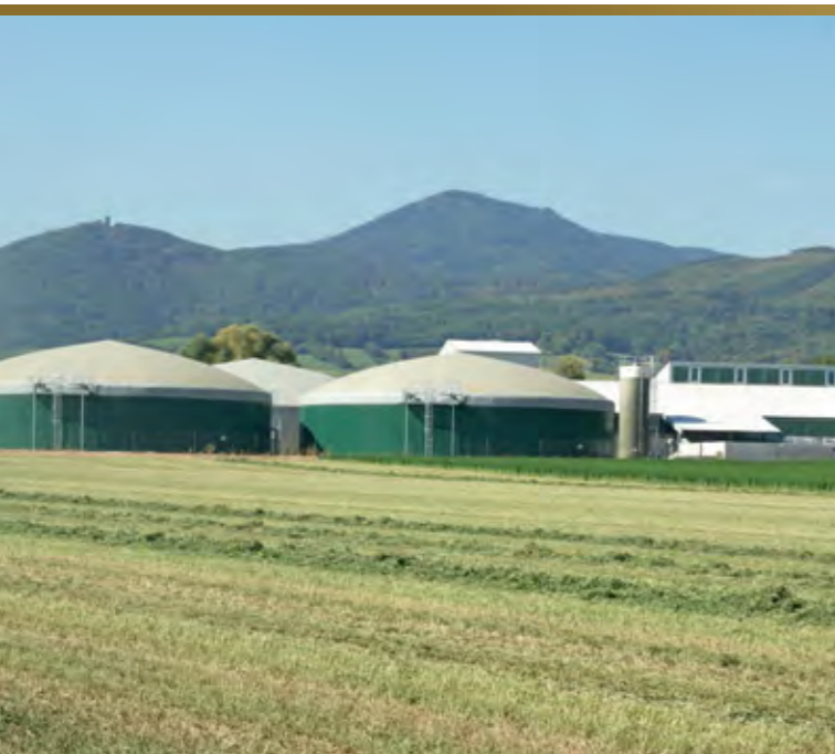
← Agrivalor : vue générale de l'installation
